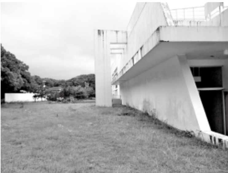
避難タワー建設予定地（大方あかつき館裏）
